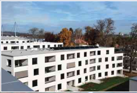
Wohnhäuser im Agy Parc mit Solarwärme-Anlagen auf den Dächern.
