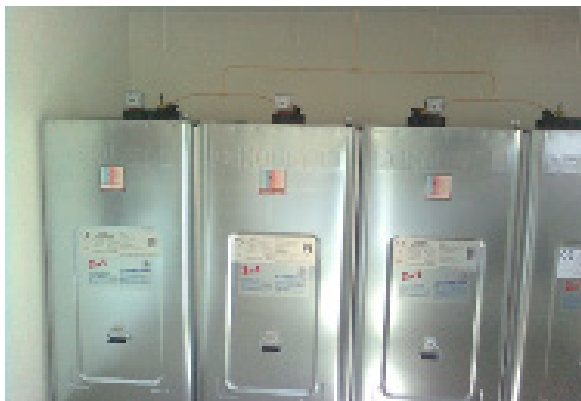
Neuinstallationen für Kleinanlagen
