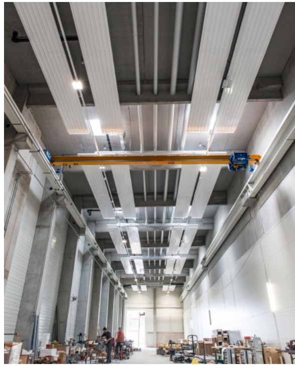
Liebherr Machines, Bulle Dampf-, Heizungs- und Kälteanlagen / Deckenstrahlplatten
