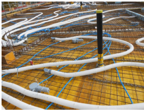
AGY-Parc, Granges-Paccot Einlagen für kontrollierte Lüftung
