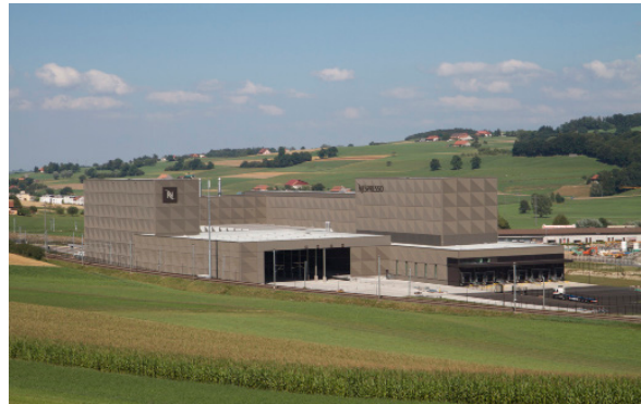
Nespresso, Romont Heizungs- und Kälteanlagen.
