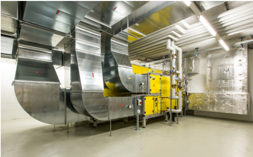
École de Marly Monoblock mit Plattenwärmetauscher
