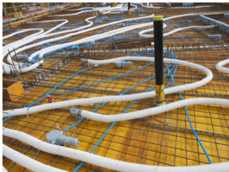
AGY-Parc, Granges-Paccot Einlagen für kontrollierte Lüftung
