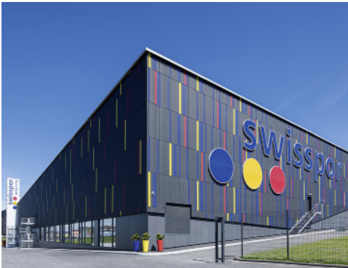
Swisspor I und II, Châtel-St-Denis Système vapeur et installation de chauffage
