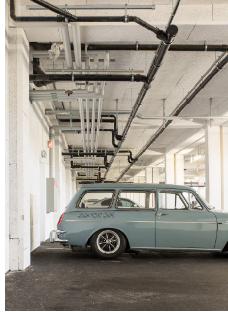
Rue François-d'Alt (Gainerie), Fribourg Conduites d'alimentation et d'évacuation
