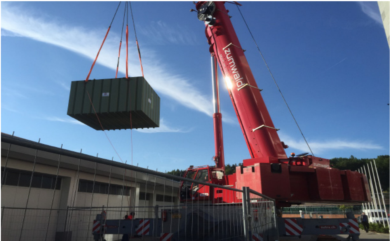
Neuinstallationen für Grossanlagen
