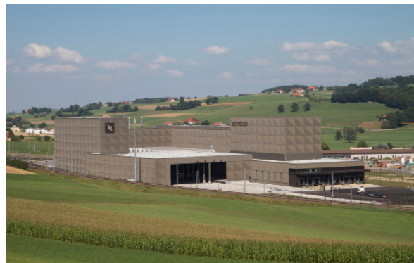
Nespresso SA, Romont Installations de chauffage et froid
