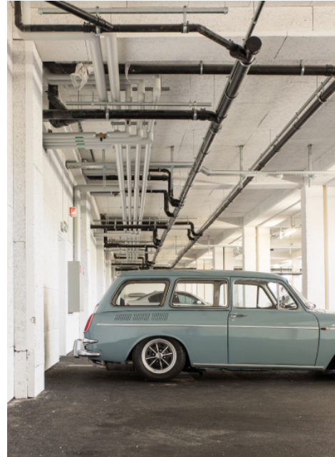
Rue François-d'Alt (Gainerie), Fribourg Ver- und Entsorgungsleitungen
