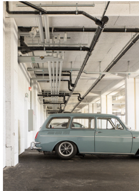
Rue François-d'Alt (Gainerie), Fribourg Ver- und Entsorgungsleitungen
