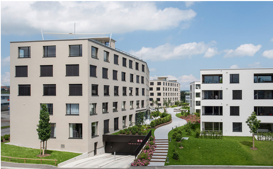
Construction Agy-Parc, Granges-Paccot Réseau de chauffage à distance — Distribution de chaleur par chauffage au sol et radiateurs combinés
