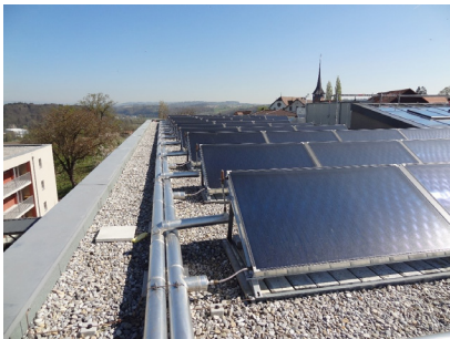
Home médicalisé Bösingén Système solaire thermique comme chauffage d'appoint et production d'eau chaude sanitaire
