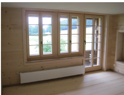
Transformation d'une ferme, Pierrafortscha Distribution de chaleur par radiateurs
