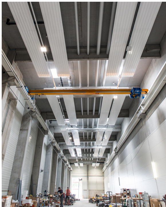
Liebherr Machines SA, Bulle Inst. vapeur, chauffage et froid / Panneaux rayonnants de plafond
