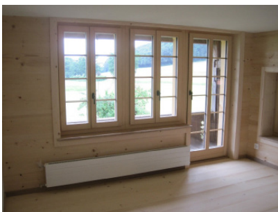
Umbau Bauernhaus, Pierrafortscha Wärmeverteilung mit Heizkörpern
