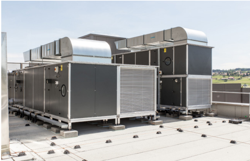
Nespresso PC3, Romont Monobloc en toiture
