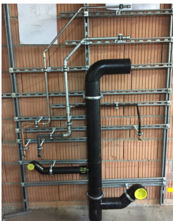
Mur de montage exécuté par un apprenti, après les cours int. entreprise
