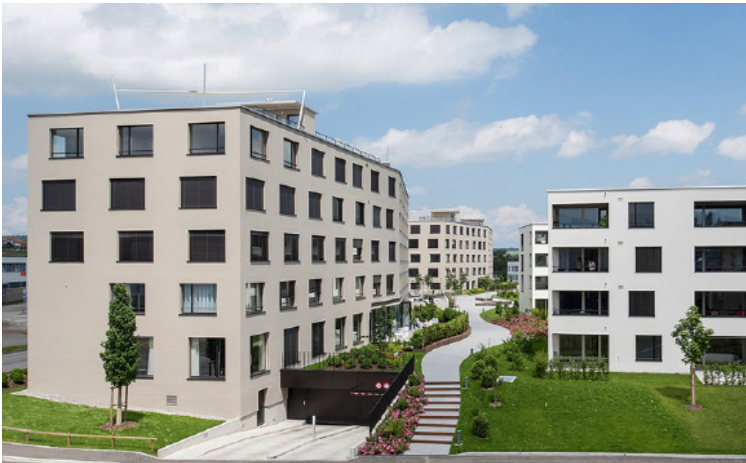
Construction Agy-Parc, Granges-Paccot Réseau de chauffage à distance — Distribution de chaleur par chauffage au sol et radiateurs combinés
