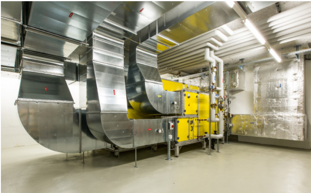
École de Marly Monobloc avec échangeur de chaleur à plaques
