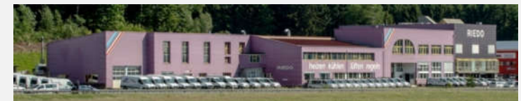
Wir sind ihr Gebäudetechnik-Partner für Wohnungsbau, öffentliche Bauten, Gewerbe und Industrie
